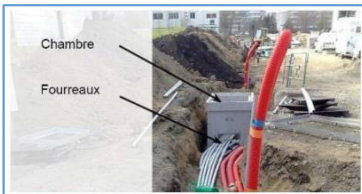
Figura 6: Composição de uma infraestrutura de recepção de fibra ótica terrestre.
