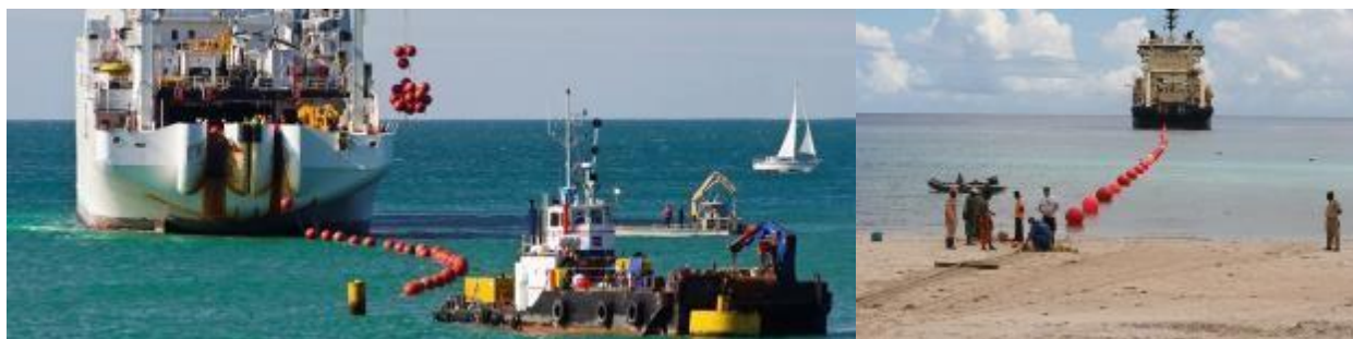
Foto 3: Ligação do cabo à estação final (amarração na praia)
